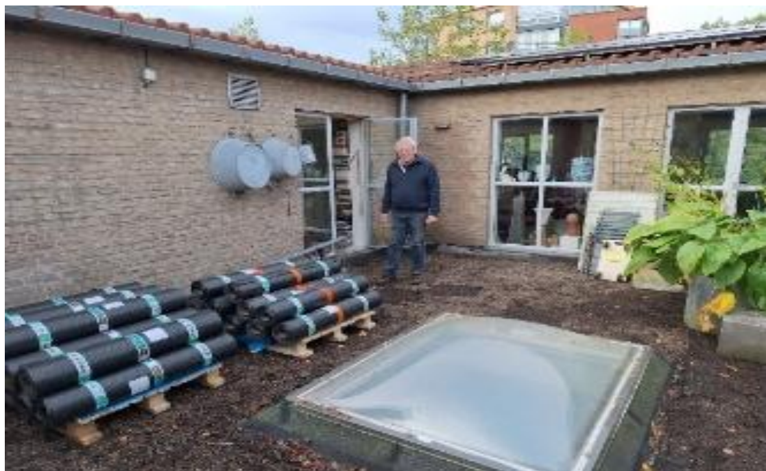
reparatie door de VVE van de Patio
